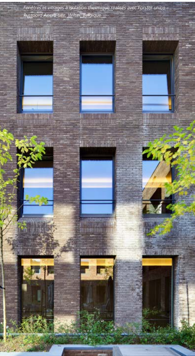
Portes et cloisons coupe-feu EI30 réalisées avec Forster fuego light – Piscine les Argoulets, Toulouse, France
