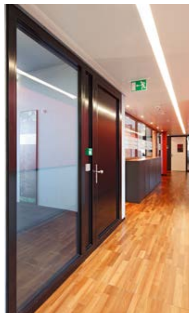
Vitrages anti-effractions à isolation thermique – KBA NotaSys, Lausanne, Suisse
