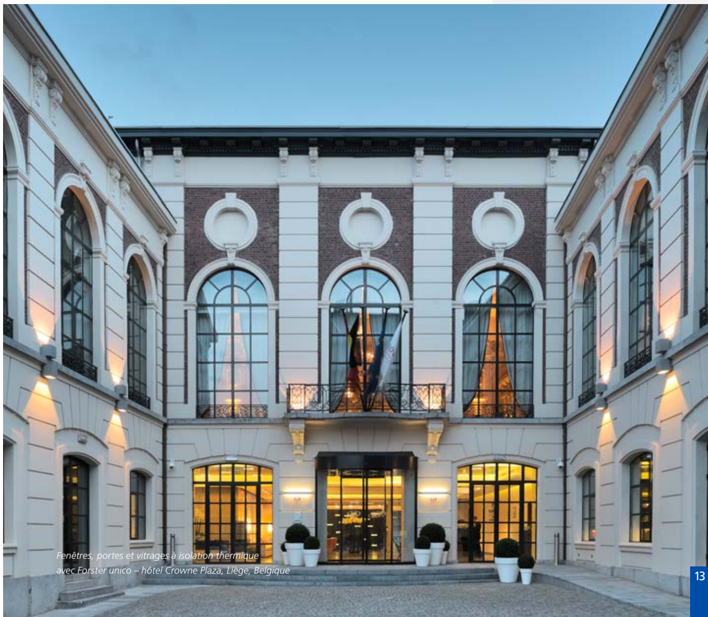
Façade et verrière de la «Limonai», entièrement restaurée avec le système Forster thermfix vario – musée Stibbert, Florence, Italie
