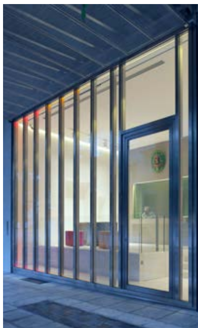
Porte et vitrage anti-effraction en acier inox – Ambassade de Belgique, Athènes, Grèce
