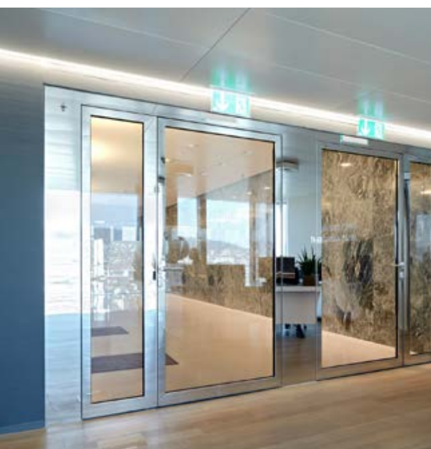
Portes coupe-feu en acier inox EI30 – Prime Tower, Zurich, Suisse
