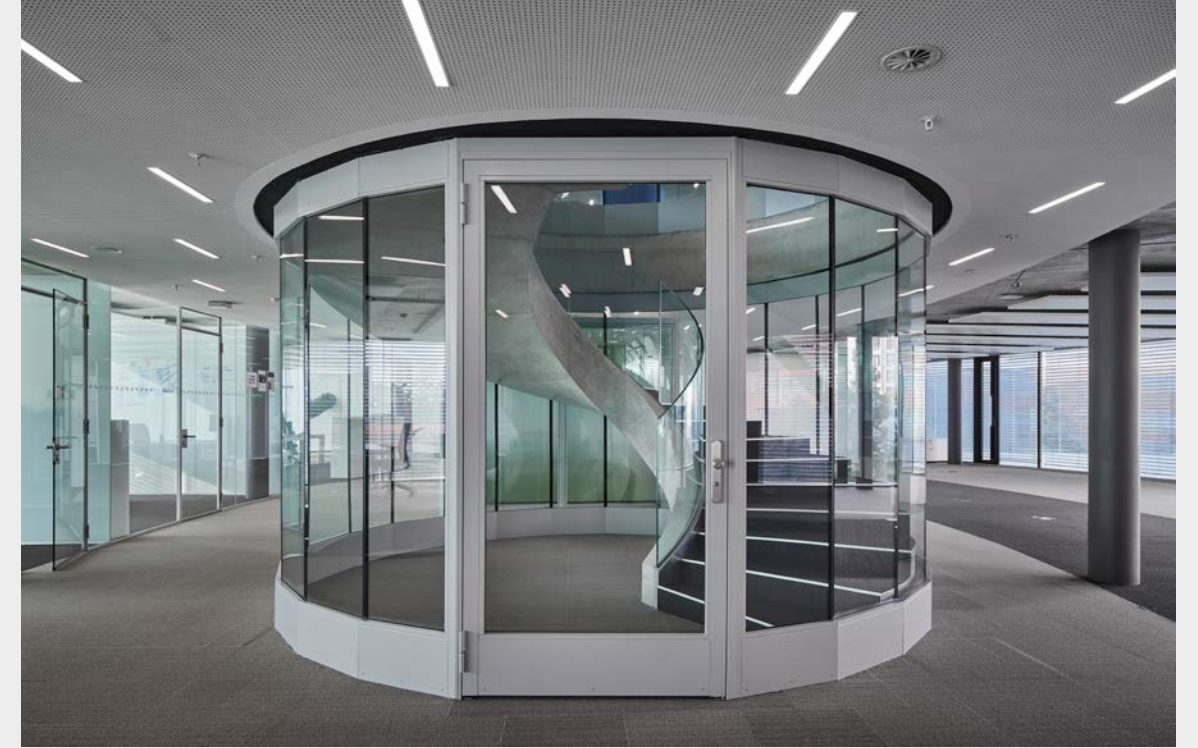
Maison de la Paix, Genève, Suisse Portes coupe-feu à un et deux vantaux – forster fuego light El230 Éléments de verre assemblés avec des joints vifs – forster fuego light El230/El260 Photo: Damian Poffet
