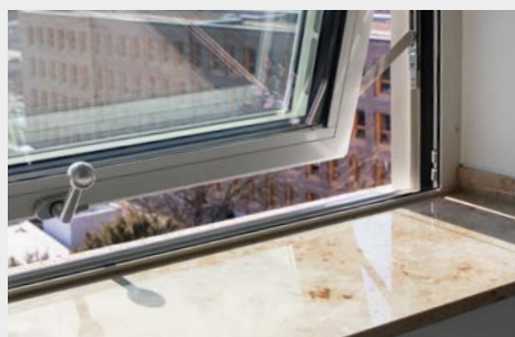
Bâtiment des sciences économiques et sociales de l'Université de Cologne, Cologne, Allemagne Fenêtre à caisson avec brise-soleil intégrée – forster unico HI Photos: Jens Kirchner
